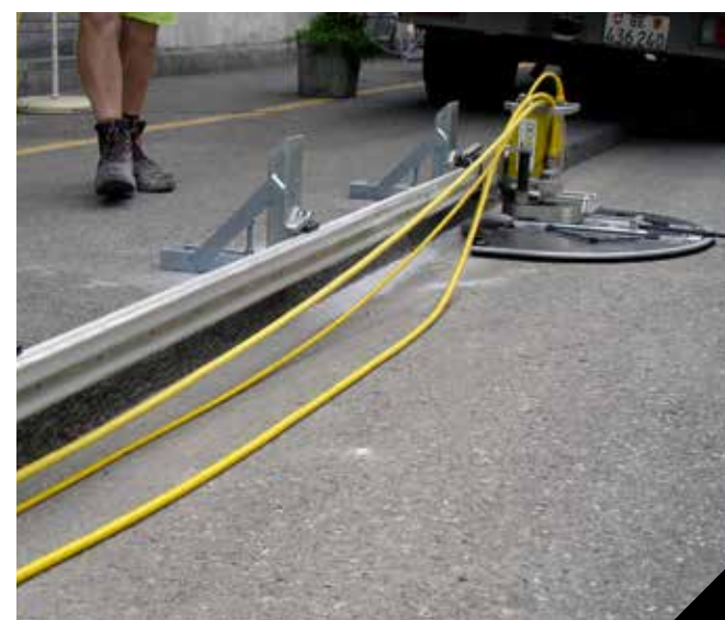
L'ÉQUIPEMENT SPÉCIAL BORDURES S'AVÈRE IDÉAL POUR LES ABAISSEMENTS DE TROTTOIR SANS TOUCHER À LA ROUTE
