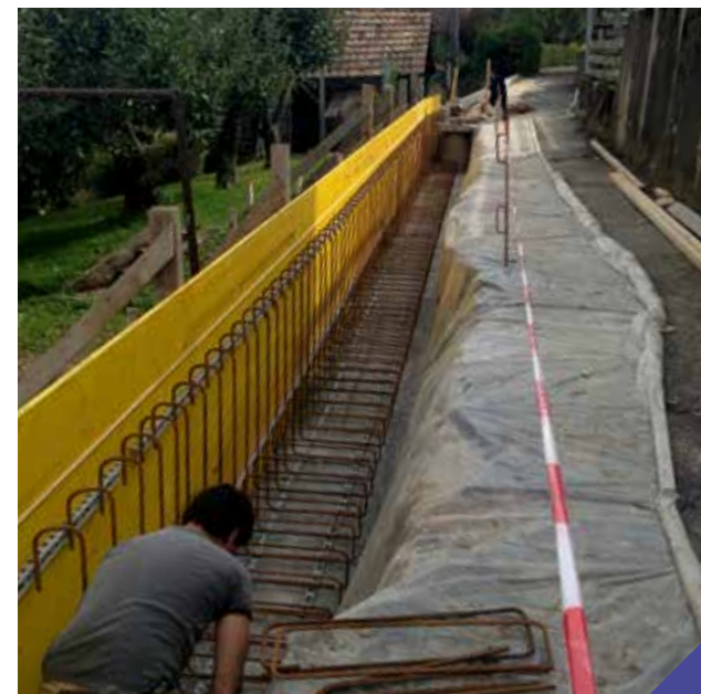
RECONSTRUCTION D'UN MUR DE SOUTÈNEMENT EN BÉTON
