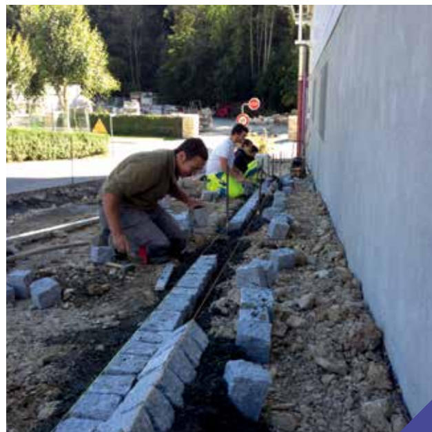
POSE DE PAVÉS DE BORD
