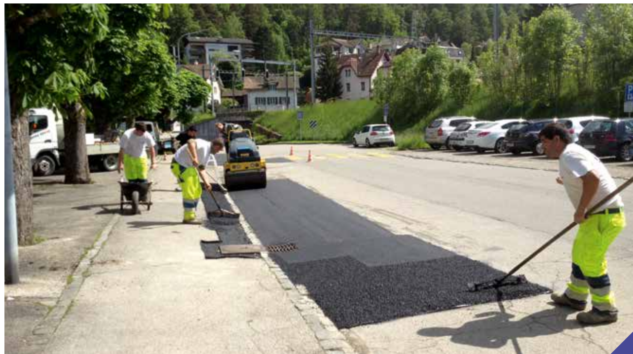
NOUS RÉALISONS LES TRAVAUX DE POSE DE REVÊTEMENT À LA MAIN OU À LA MACHINE, DE LA PETITE FOUILLE À LA PLACE OU CHAUSSÉE COMPLÈTE.
