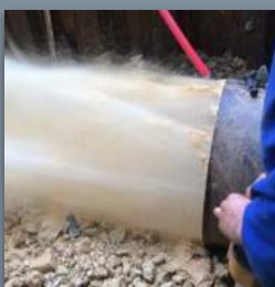
Battage du tube DN 800! Tentative de curage, et extraction manuelle des blocs
