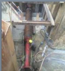
Battage du tube DN 800! Tentative de curage, et extraction manuelle des blocs
