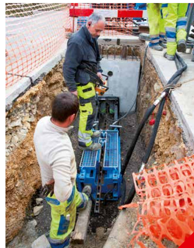
FOSSE DE TIRAGE: PEU D'EMPRISE SUR LA CHAUSSÉE
