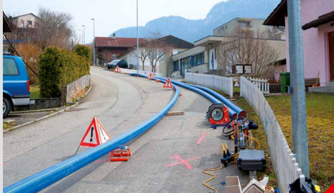
FOSSE D'INTRODUCTION: LES TUBES SONT PRÉPARÉ À L'AVANCE
