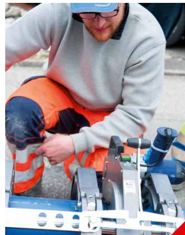
L'ASSEMBLAGE DE CHAQUE NOUVELLE CONDUITE PE, FONTE OU PVC, NÉCESSITE UNE ATTENTION PARTICULIÈRE ET UNE TECHNIQUE D'ÉCLATEMENT SPÉCIFIQUE.
